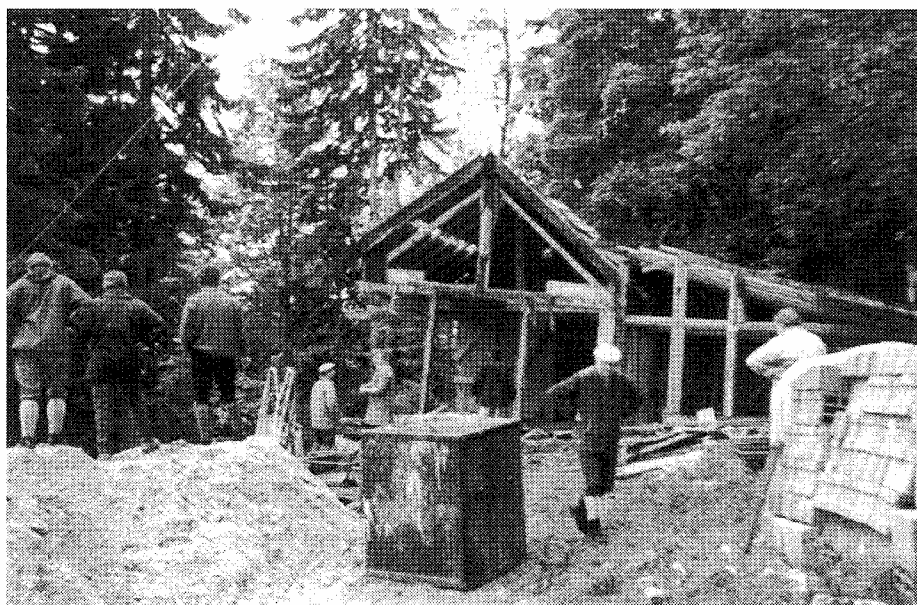
Abbruch des Pferdestalles
