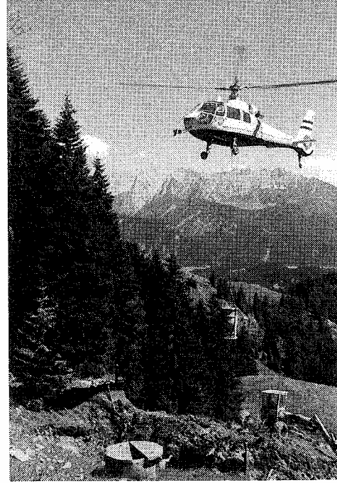
Hubschrauber bei der Erweiterung der Wasserversorgung 1985
