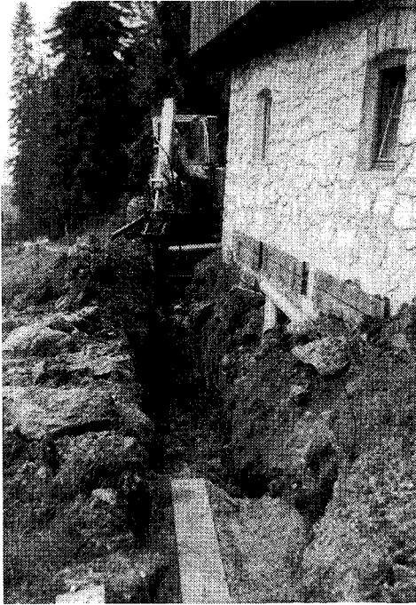
Bau der Kläranlage 1985
